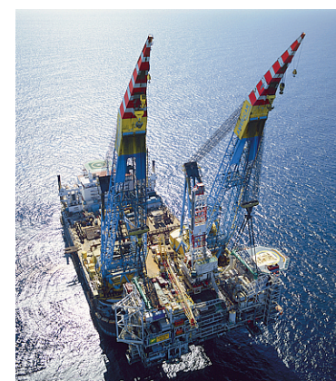
Mare del Nord La Saipem 7000, nave per il sollevamento di strutture e posa in opera di condotte
