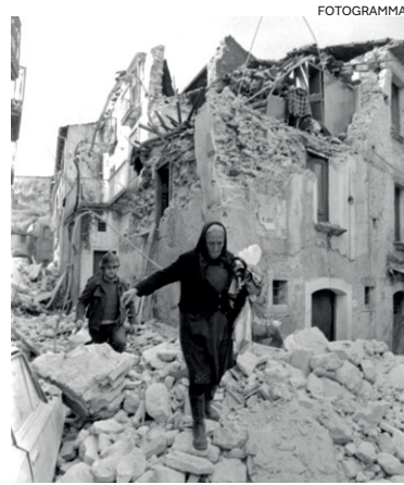
In Irpinia Balvano distrutta dal terremoto del 1980
